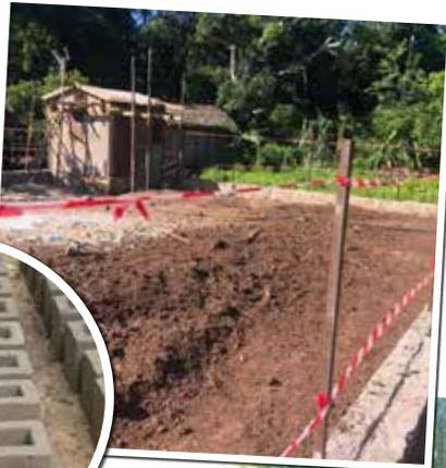
Tandis que les parpaings sont fabriqués à la main sur place, **on sécurise le terrain**, car une école est à côté du chantier. Tous les élèves sont informés des travaux et ont interdiction d'approcher pour éviter les accidents.
