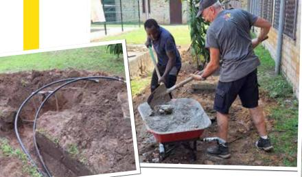
Une fois remblayée, la terrasse en béton est restaurée pour mettre installer **un robinet extérieur** en remplacement d'une pompe manuelle.
