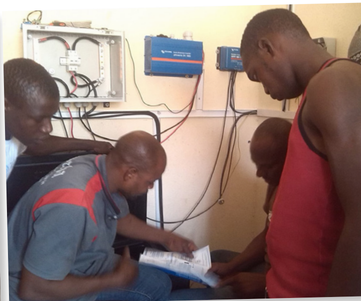
Les techniciens de l'entreprise Seeba
