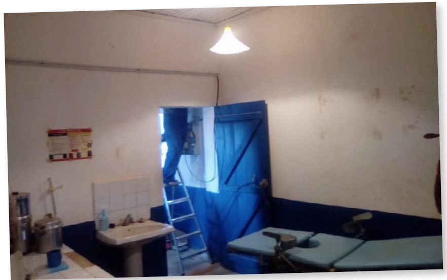
Les travaux d'électrification de l'hôpital
