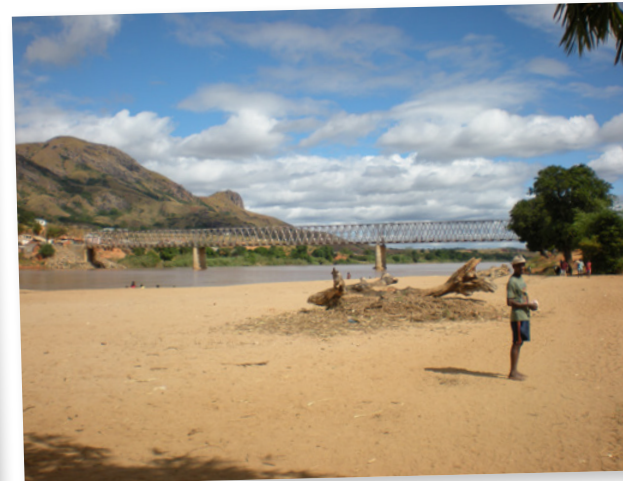
Vue du pont depuis la berge du fleuve
