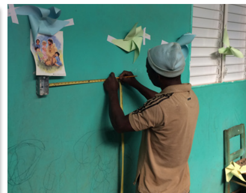
Pose des interrupteurs
