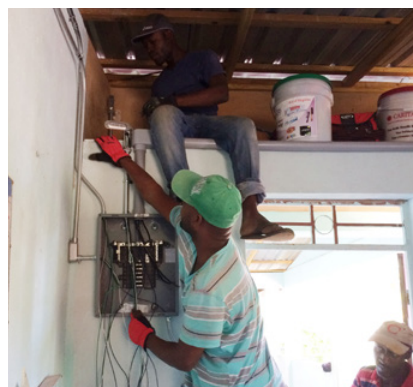
Pose du tableau électrique
