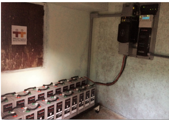
Mise en service des batteries
