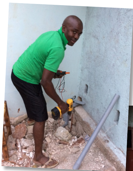
Une mesure de sécurité indispensable avant la mise en service : relier le réseau électrique à la terre
