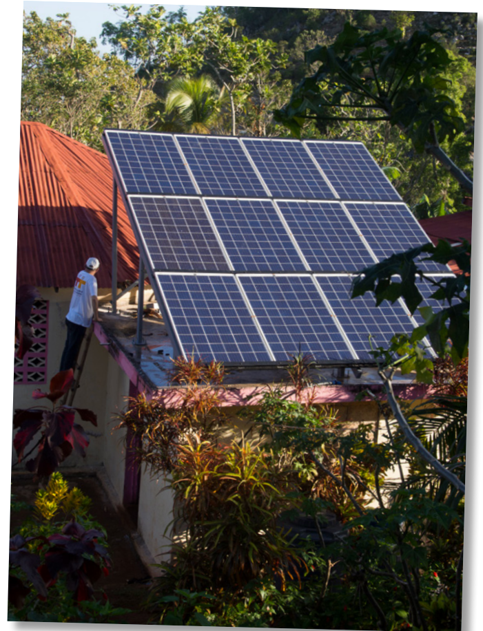
Vérification des panneaux installés
