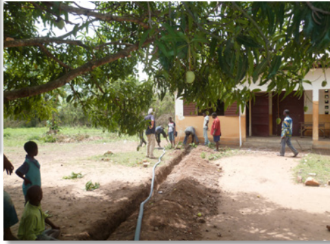
Défrichage, réalisation de la tranchée pour le passage du câble
