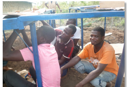
Structure supportant les panneaux photovoltaïques
