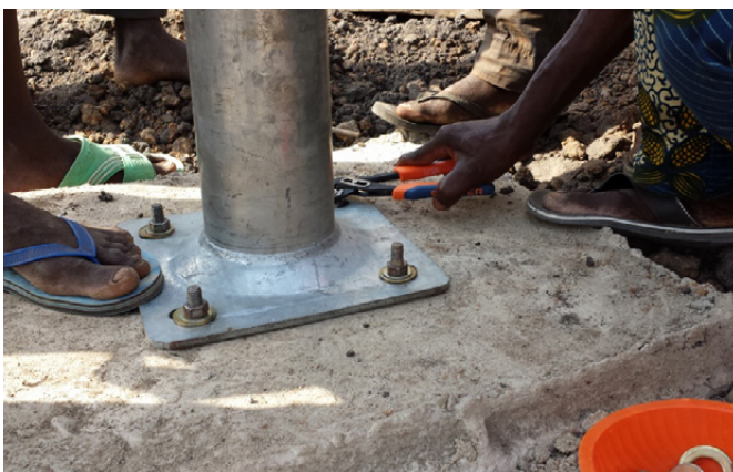
Le poteau est fixé à sa base sur un socle en béton
