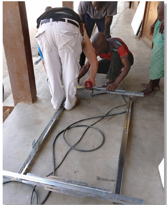
Confection d'un cadre qui supportera un panneau solaire
