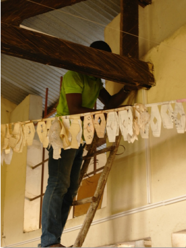
Fixation des câbles électriques
