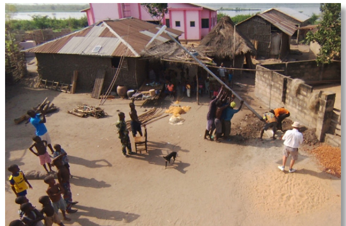
Il faut être plusieurs pour lever le poteau électrique
