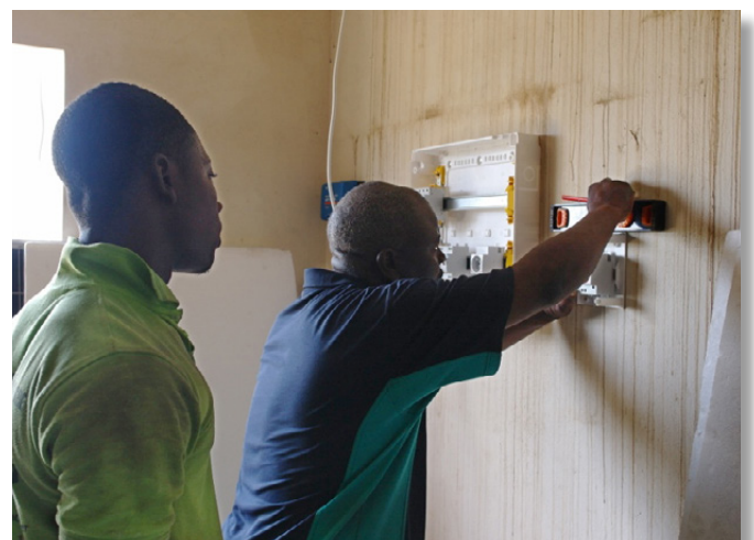
Installation du tableau électrique
