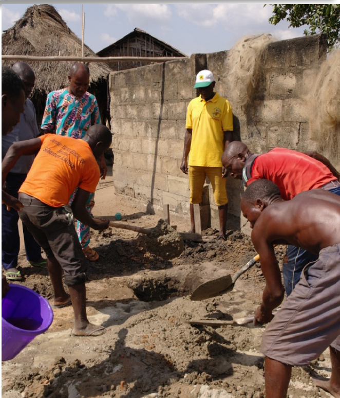
Terrassement pour le futur lampadaire
