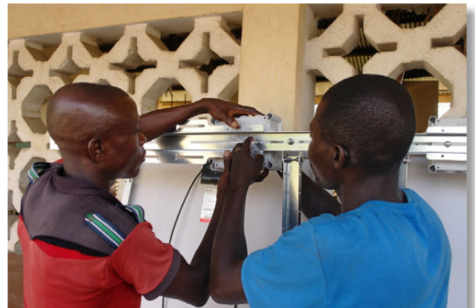
Montage d'un panneau solaire
