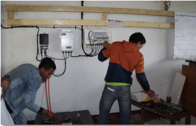
Installation du tableau électrique.
