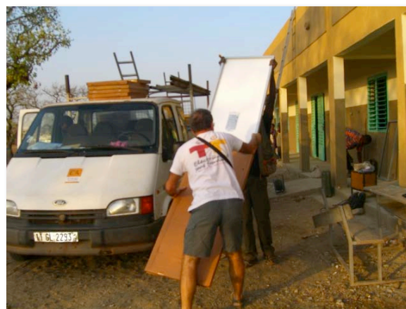
Déchargement des panneaux photovoltaïques
