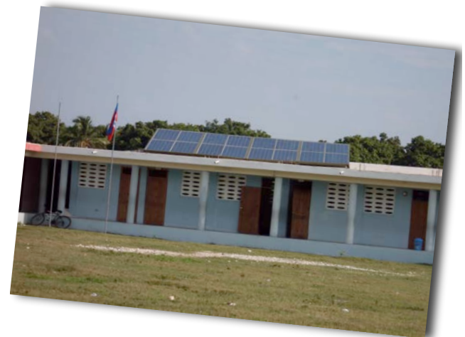
Installation des panneaux
